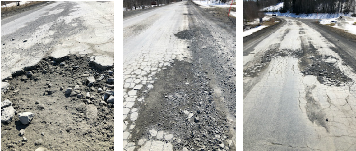
Väg 662 vid hamnen i Huså och strax öster om bron.
